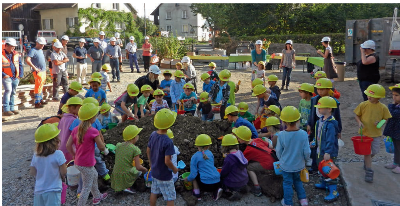
Mit ihrem Spatenstich gaben 50 Kindergartenkinder am 12. September den Startschuss für den Bau des neuen Dreifachkindergartens «Bachplätscherli».
